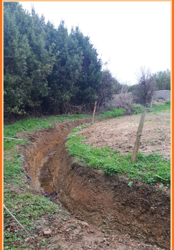
Travaux de Curage «Rue de la Chauvelière»
