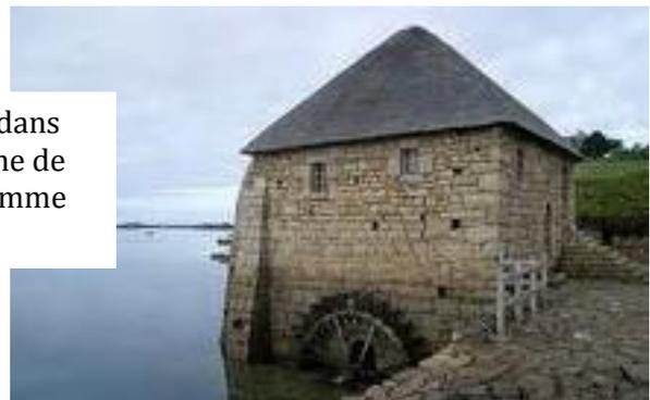
Ces moulins connaîtront une réelle expansion à partir du 12<sup>ème</sup> siècle avec l'invention de l'arbre à cames qui permet de transformer le mouvement rotatif en alternatif. Outre le moulin à farine qui broye, se créent ainsi des moulins qui pilent et qui martèlent :
